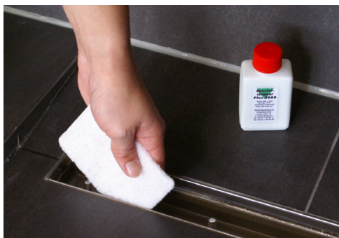
Reinigen einer CeraLine-Duschrinne aus Edelstahl V2A
